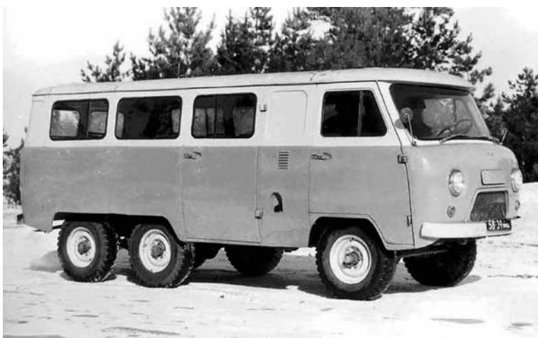
Рис. 3. УАЗ-452К (1973 г.) – экспериментальный 16-местный автобус с колесной формулой 6x4
